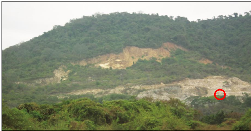
Fig. 7. Foto del deslizamiento al año 2015. Nótese la maquinaria en el círculo que pone en escala con la magnitud del evento. Fuente Garzón W.
