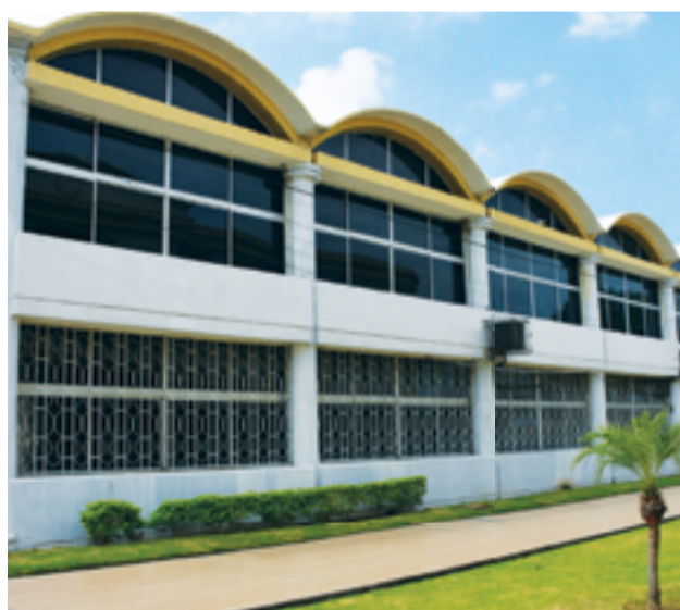
Edificio de aulas de la Facultad de Medicina veterinaria y zootecnia
