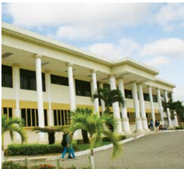
Edificio de Ingeniería en Computación e Informática
