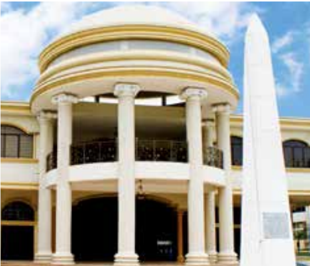
Edificio de la Administración Central
