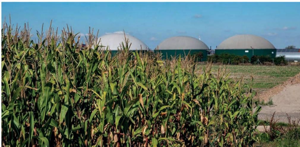
Un ejemplo de este tipo de valorización energética se encuentra en las plantas de biogás para autoconsumo en la industria alimentaria y agrícola, donde el biogás generado se utiliza para las propias necesidades energéticas. Además, los residuos resultantes del proceso pueden transformarse en compost y fertilizantes orgánicos, cerrando así el ciclo de producción de manera sostenible.
